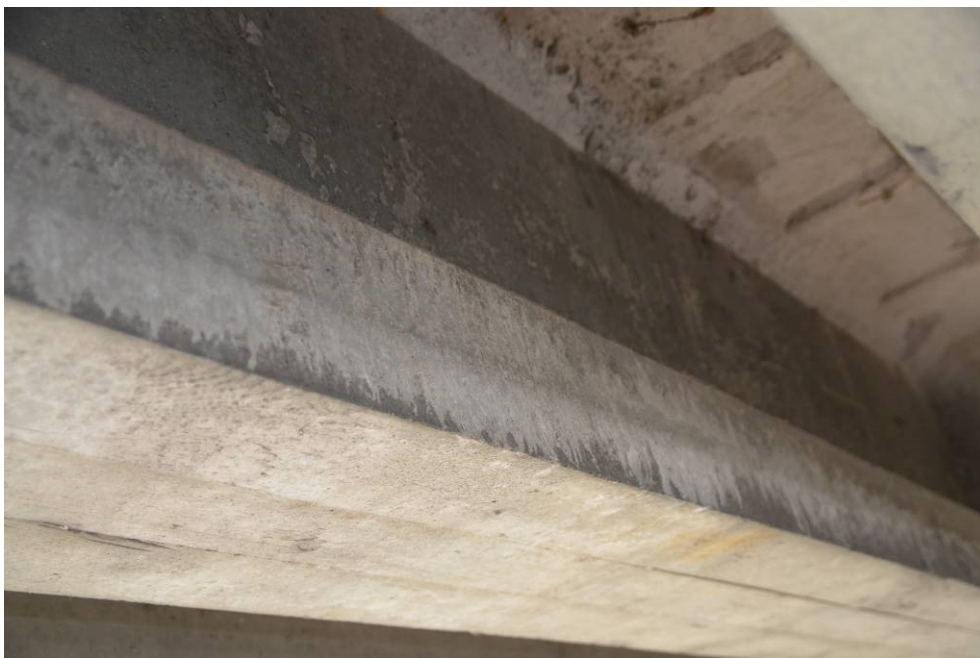
Obr.F41-34 Podélná trhлина v levé stěně dolní příruby nosníku č.8 přibližně v polovině rozpětí prvního pole,
