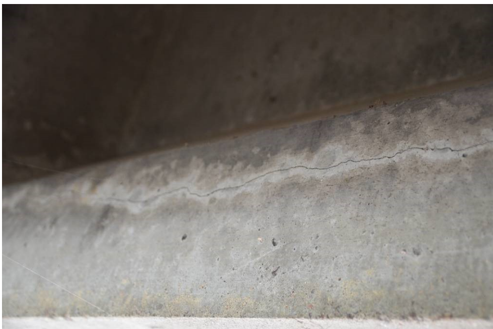
Obr.F41-36 Podélná trhлина v levé stěně dolní příruby nosníku č.5 před první čtvrtinou rozpětí druhého pole,
