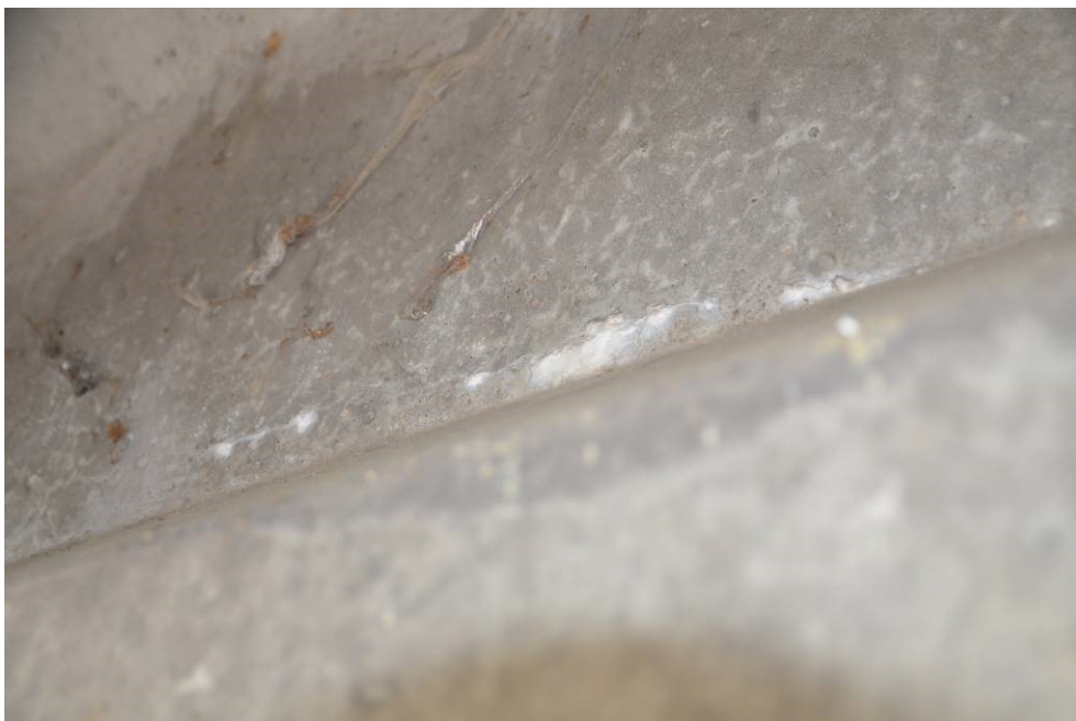
Obr.F41-37 Podélná trhlina dolní části pravé stěně stojiny nosníku č.3 za první čtvrtinou rozpětí druhého pole,
