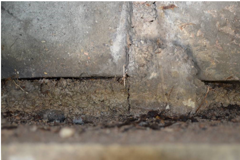
Obr.F41-25 Typický příklad nežádoucího zatečení betonu při betonáži podélné spáry do spáry úložné,
