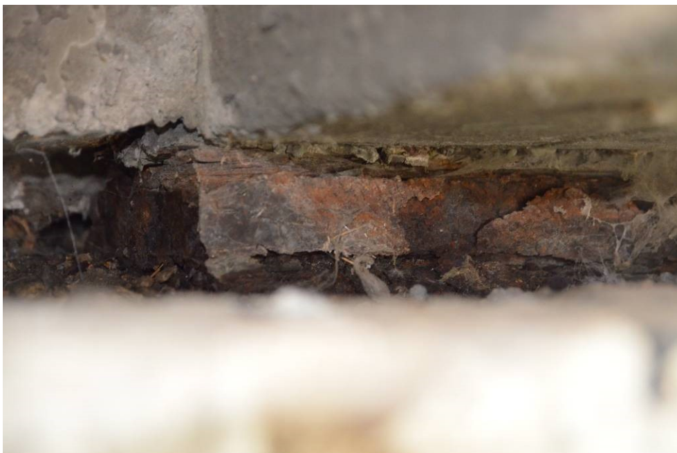
Obr.F41-45 Ložisko pod nosníkem č.2 druhého pole na 2. (mezilehlé) podpěře. Pohled proti směru staničení,
