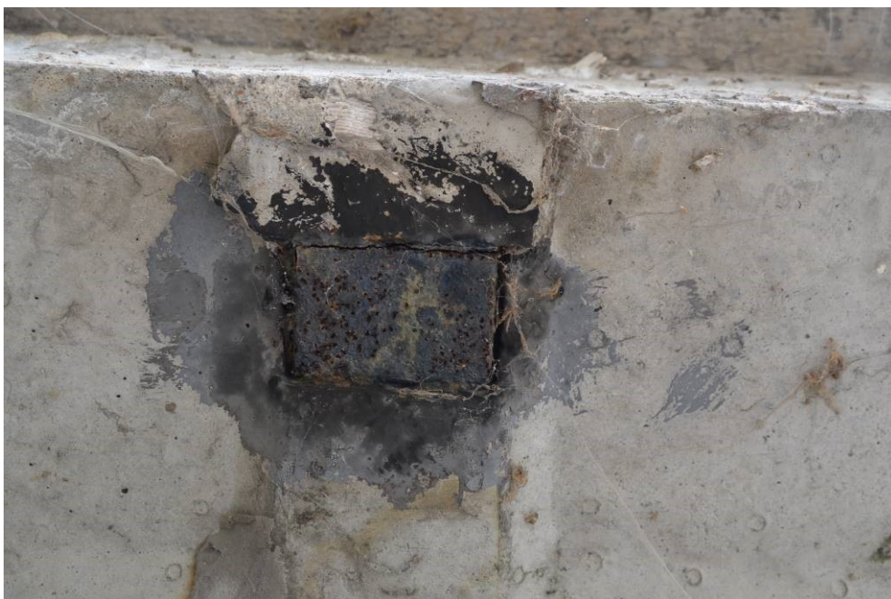
Obr.F41-24 Detail dolní plochy kotvy příčné předpjaté výztuže v místě žebra na podhledu horní desky fasádního nosníku č.10 na začátku prvního pole.
