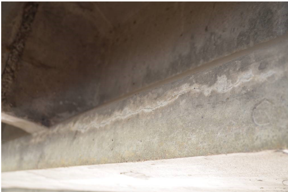
Obr.F41-35 Podélná trhлина v levé stěně dolní příruby nosníku č.5 před první čtvrtinou rozpětí druhého pole,
