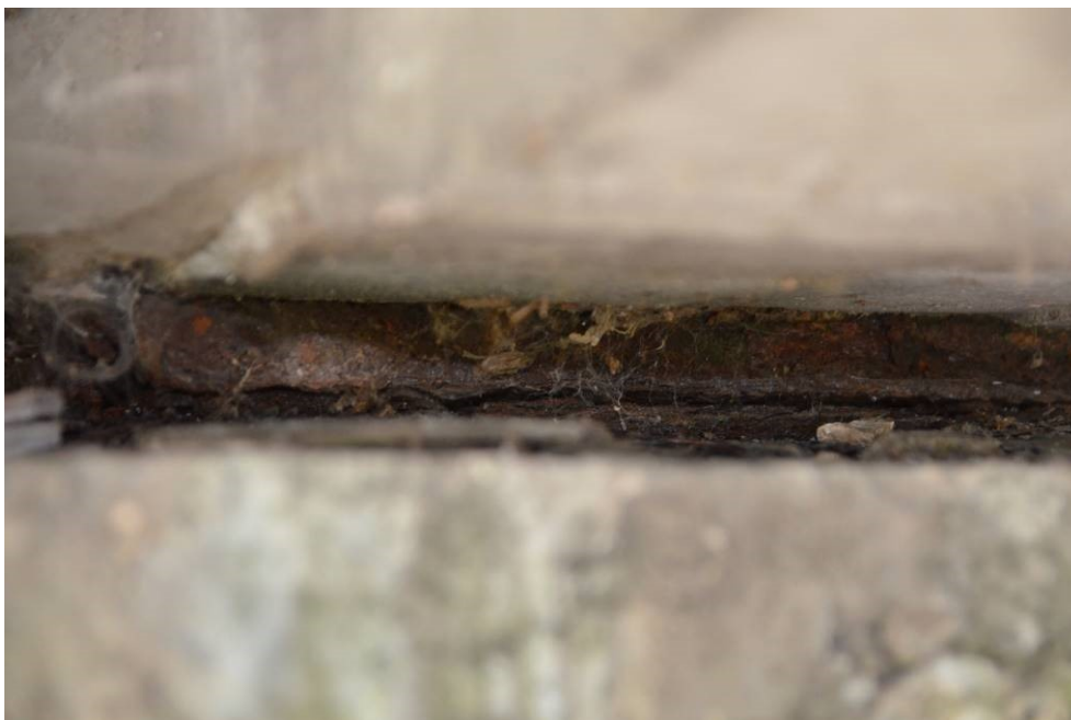
Obr.F41-43 Ložisko pod nosníkem č.8 prvního pole na 1. podpěře, nasavrcké opěře. Pohled proti směru staničení,
